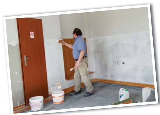
Stażysta Gminnego Ośrodka Kultury w Przygodzicach podczas prac remontowych świetlicy wiejskiej w gminie Przygodzice
